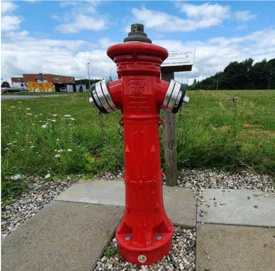
Poteau incendie avec bouchon VIDI Caps. L'utilisation d'un poteau incendie affecte la pression de la zone où il se trouve. Grâce au bouchon installé, il devient plus facile de faire la distinction entre une fuite et l'utilisation d'un poteau.
