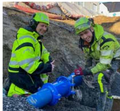
*"Le raccord Supa One™ est très facile à installer. Le serrage à l'aide d'une visseuse et d'une clé dynamométrique à 150 Nm fonctionne très bien." Kaare Mortensen A/S, entreprise norvégienne.*
