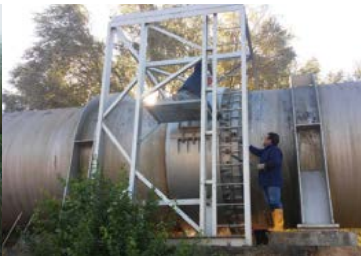
Après réparation avec manchon AVK
