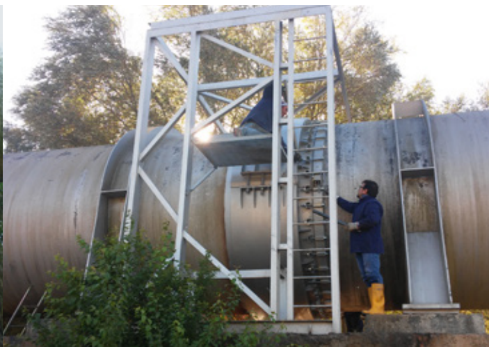
Après réparation avec manchon AVK
